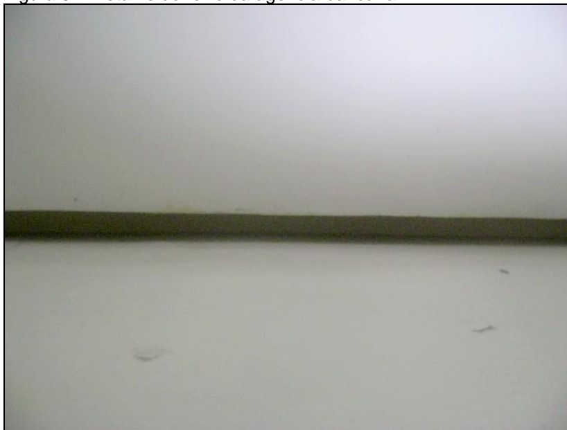
Figura 9 – Detalhe do forro da agência bancária B.
