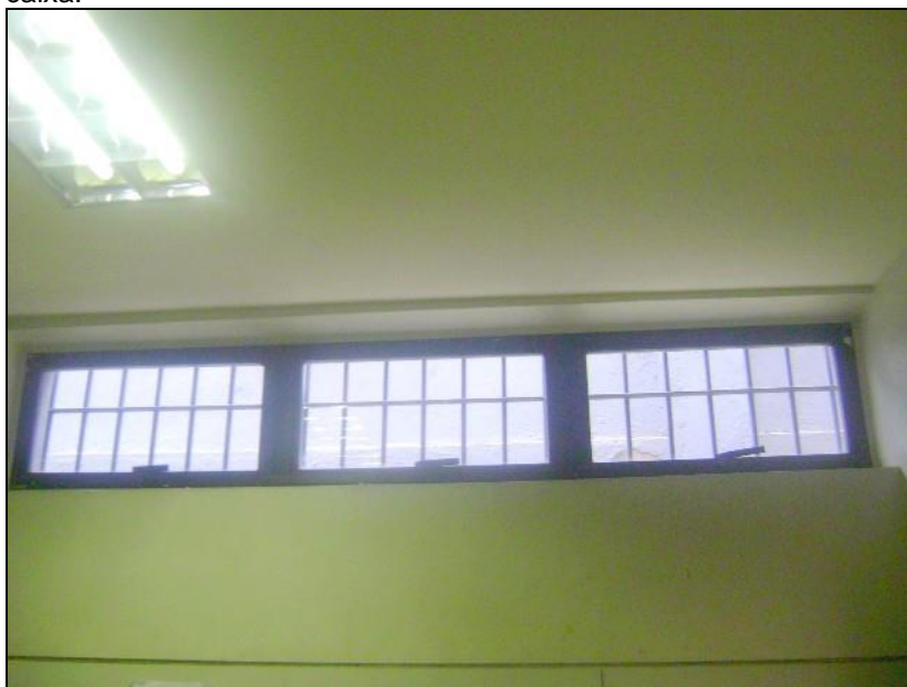
Figura 7 – Esquadria da agência bancária A, área de serviço de caixa.
