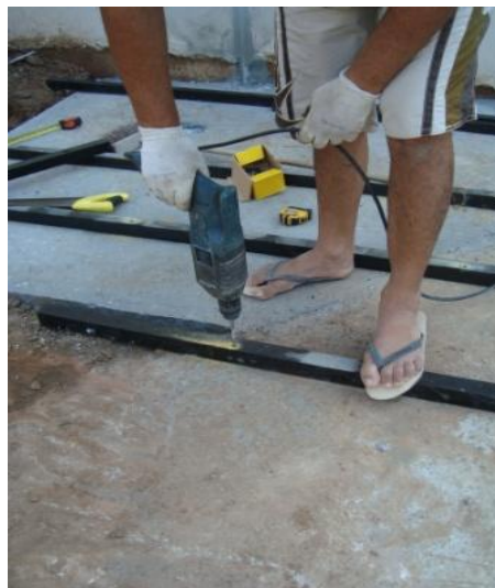
Figura 5: Atividade com furadeira sem EPIs adequados
