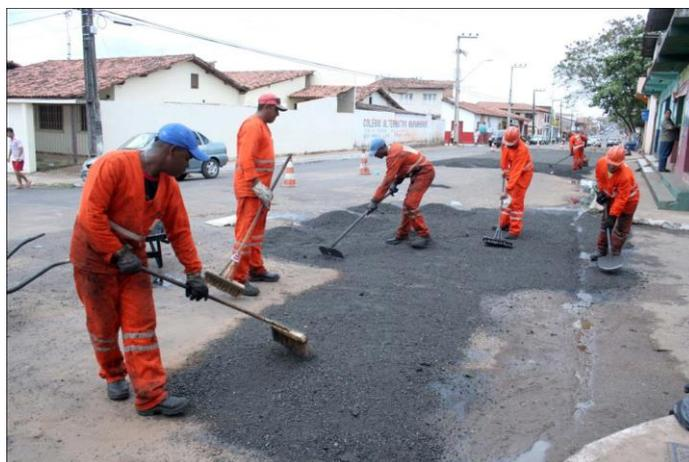
Fig. 02 – Equipe da SEMOSP recuperando asfalto
