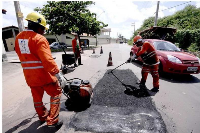
Fig. 01 - Trabalhador operando máquina compactadora .
