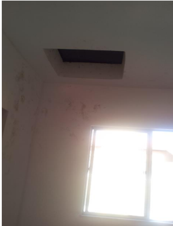
Figura 3- Acesso ao telhado
