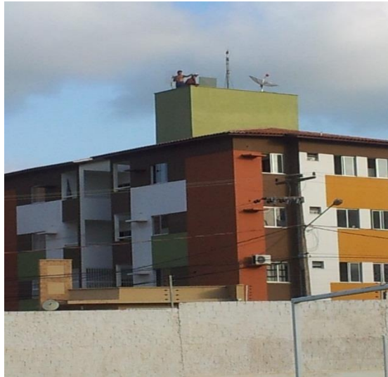
Figura 8 - trabalho em altura
