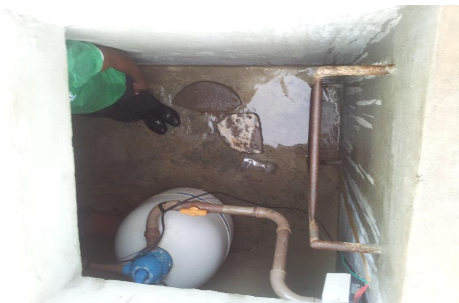
Figura 5 -Manutenção da bomba da piscina
