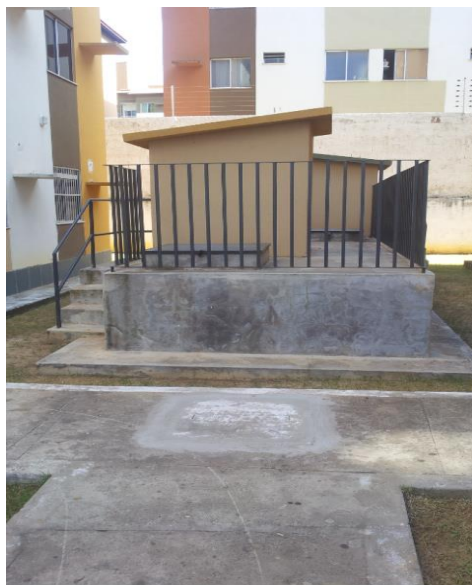
Figura 4 - Casa de bombas
