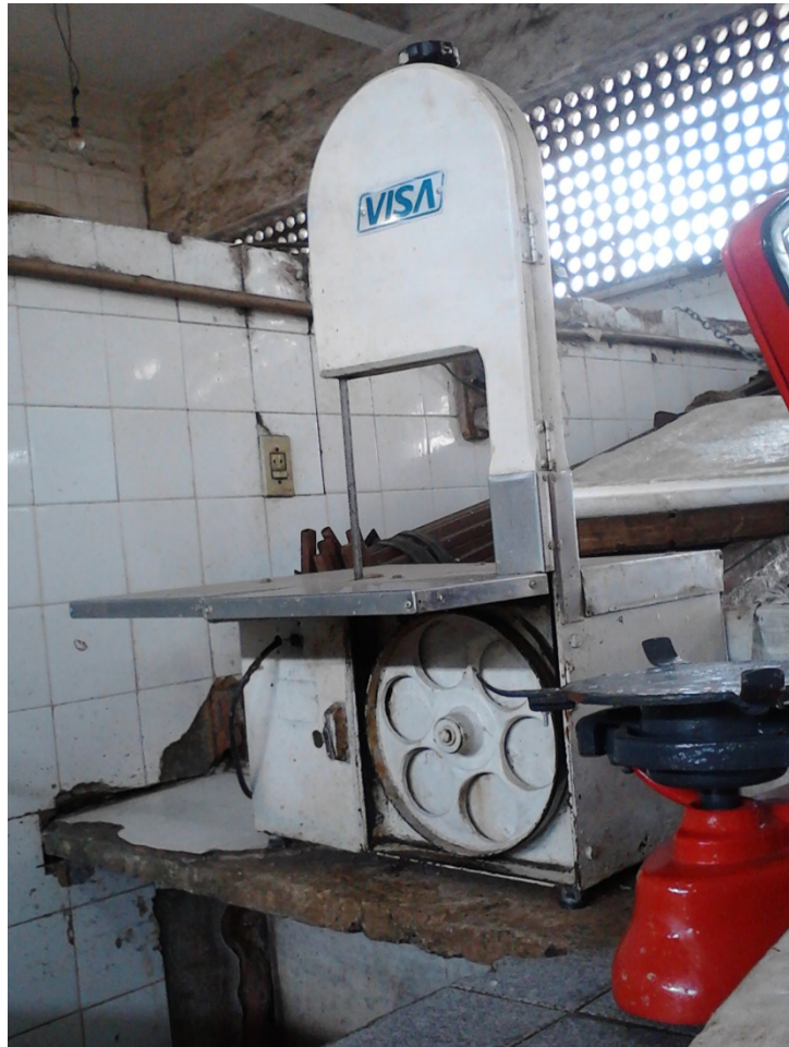
Máquina sem proteção intertravada e sinalização de segurança
