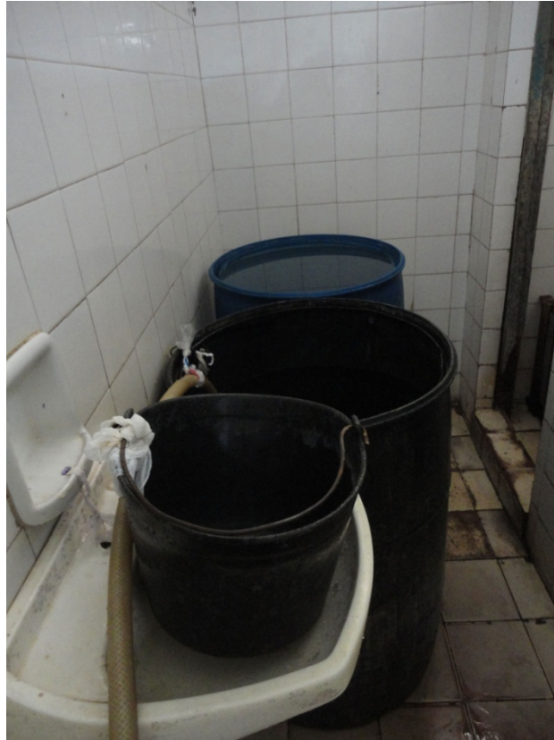
Lavatório do banheiro feminino
