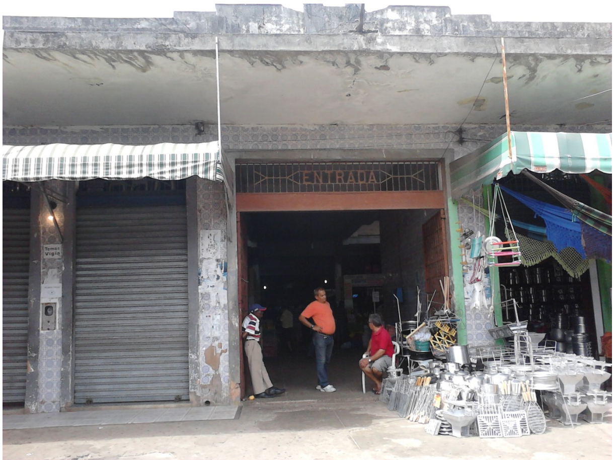
Fachada – mercado central com mercadorias obstruindo parcialmente a passagem de pessoas
