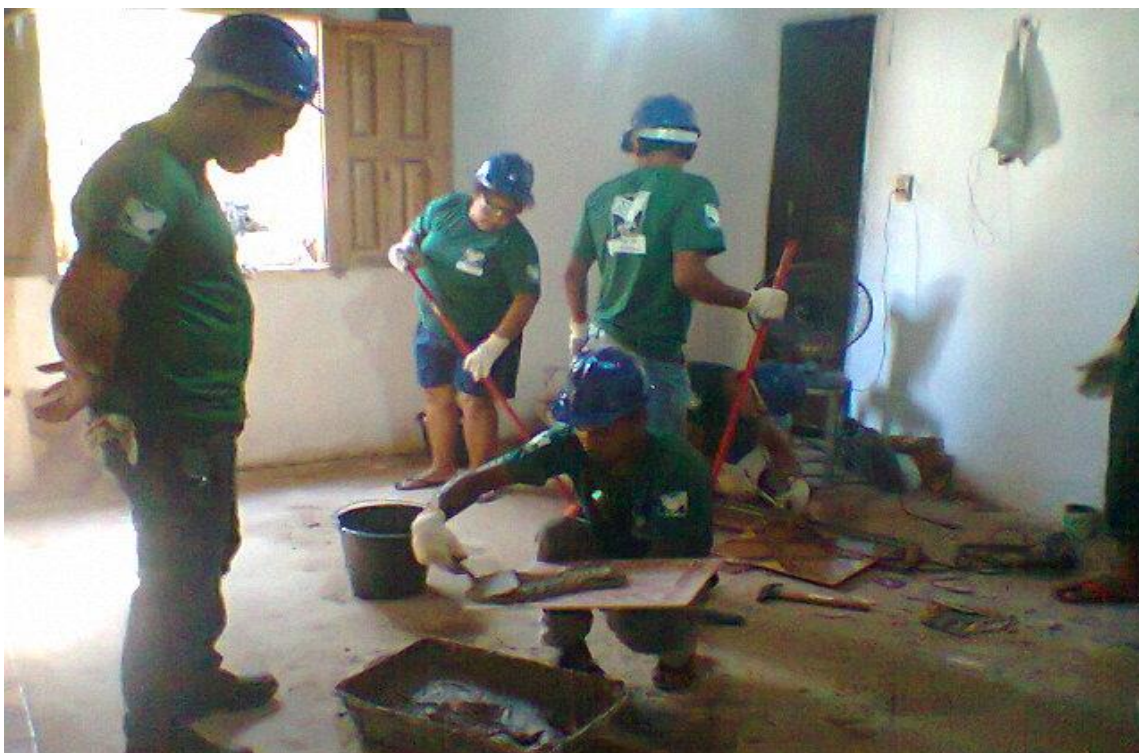
Figura 7: Treinamento para pedreiro
