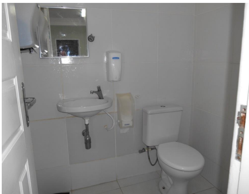
Fotografia 8 – Banheiro da Recepção
