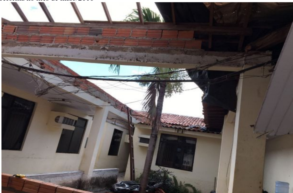
Figura 5 - Situação do fórum de São Domingos do Maranhão/MA durante processo de reforma no mês de maio/2016
