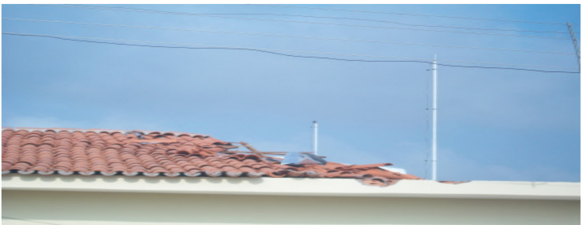
Figura 3 - Queda de parte do telhado do salão do júri do fórum de São Mateus/MA ocorrida em novembro/2011
