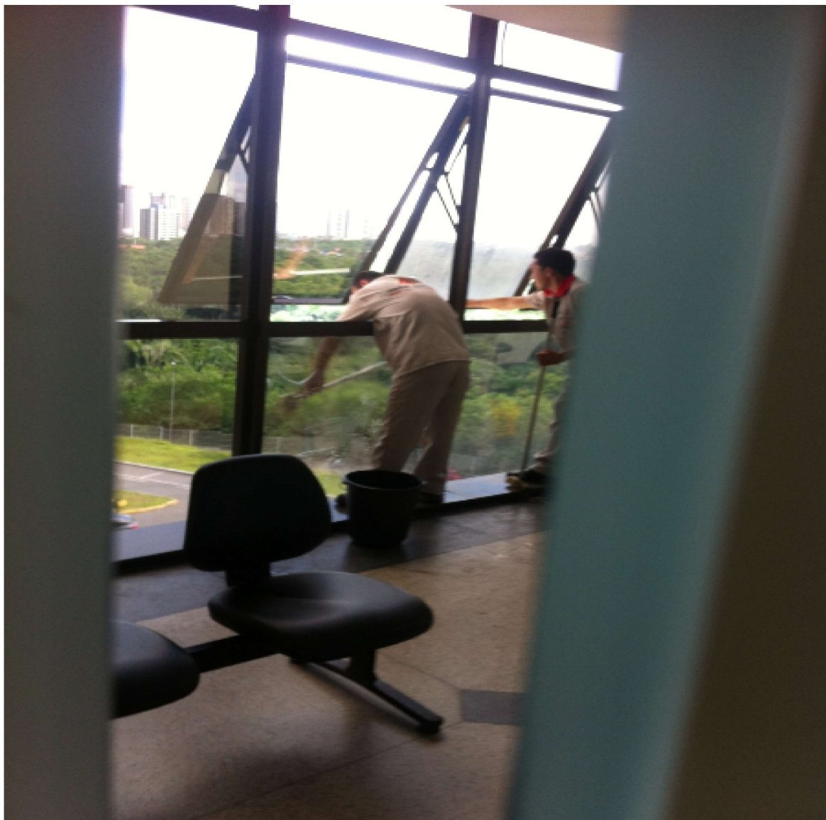
Figura 8 - Funcionários terceirizados realizando de forma indevida a limpeza dos vidros da fachada do fórum de São Luís/MA
