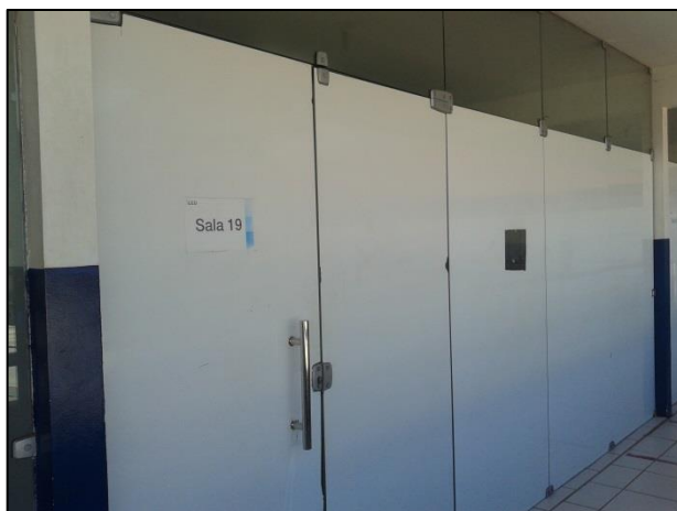
Foto 4: Sala de Aula 19 (Parede de Vidro)
