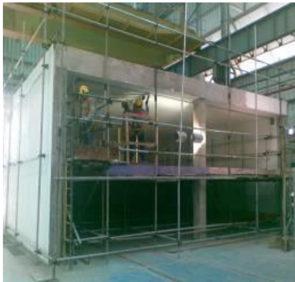
Figura 1 - Sala de Pintura Durante a Construção
