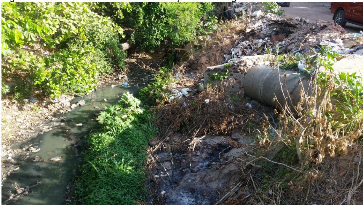
Figura 2. Descarte de material de construção em córrego do rio.
