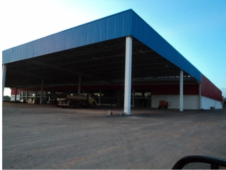
Fotos do prédio em fase de acabamento (2)
