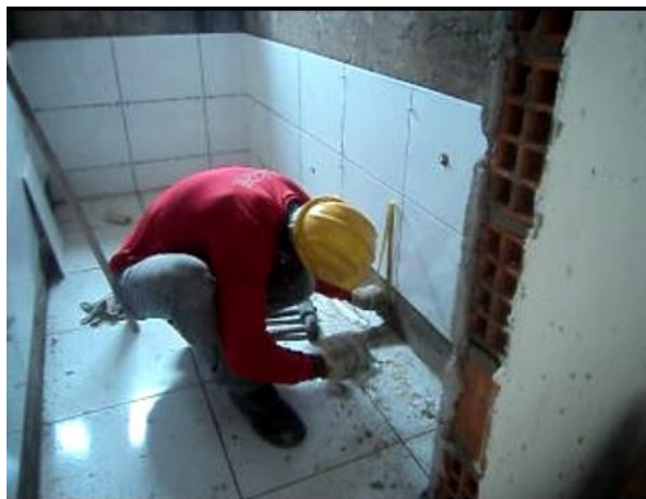
Medição do local a ser encaixada a lajota
