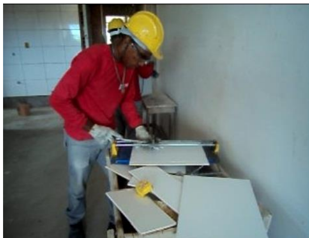
Utilização da riscadora manual para corte da lajota conforme medidas
