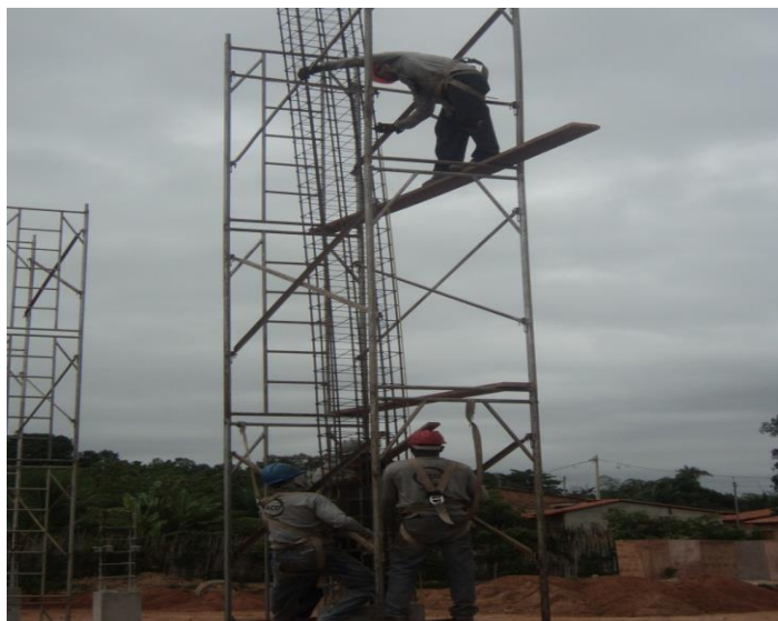
Alinhamento e Fixação da Ferragem da Coluna
