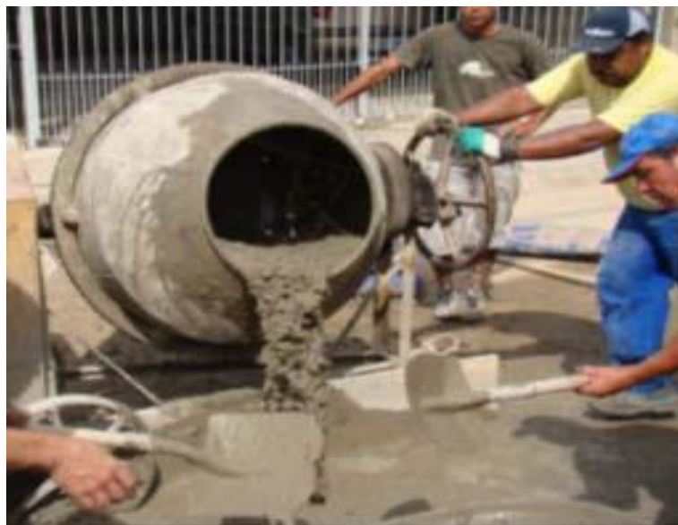
(Fig. 4) Preparação mecanizada do cimento.
