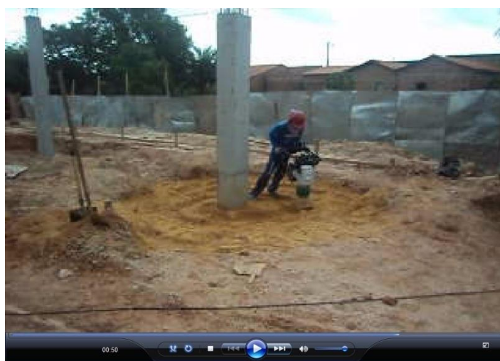
Compactação de base da coluna
