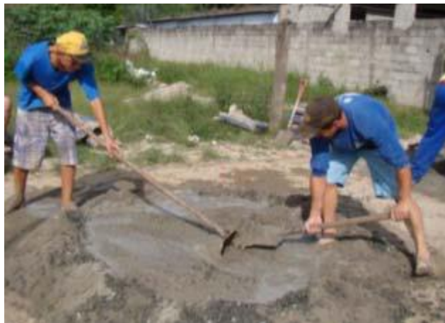
(Fig. 2) Preparação manual do cimento
