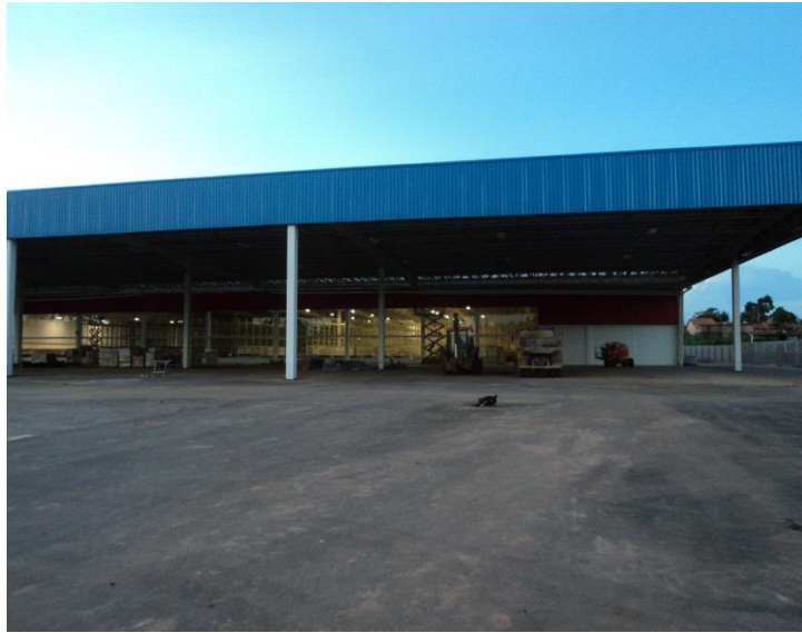
Fotos do prédio em fase de acabamento (4)
