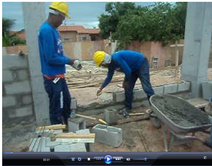
Fixações do Tijolo Pré-moldado
