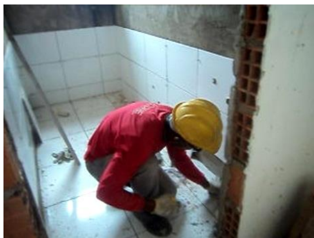
Colocação da argamassa na parede
