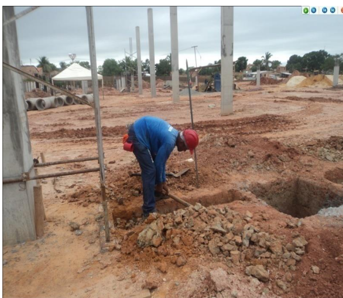
Escavação de Baldrame
