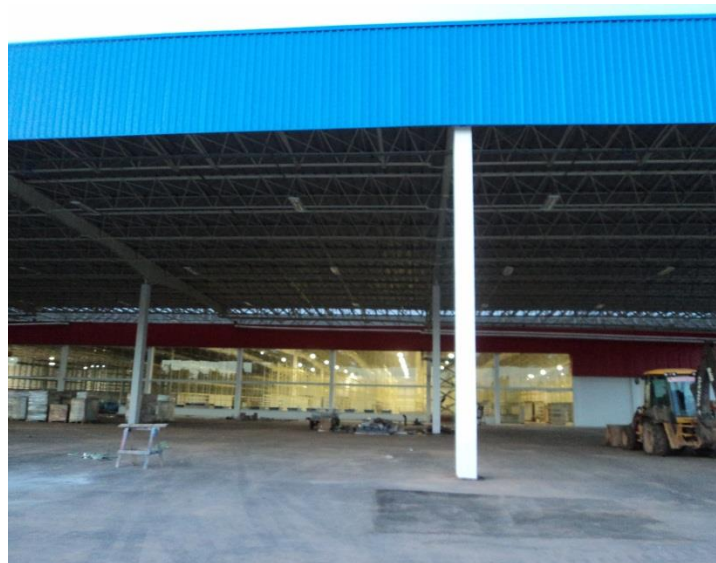
Fotos do prédio em fase de acabamento (1)
