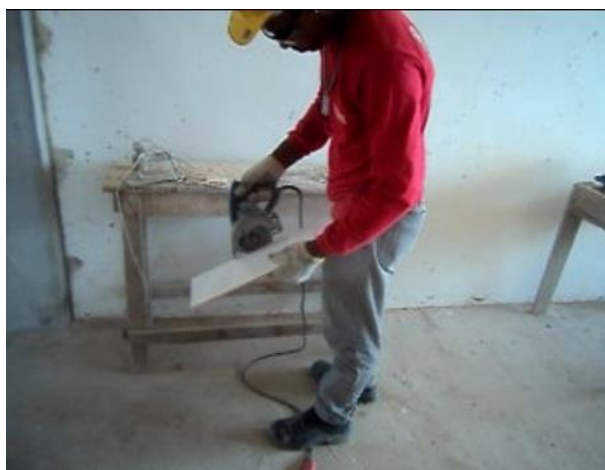
Acerto de bordas da lajota utilizando-se da máquina corta-mármore (Makita)
