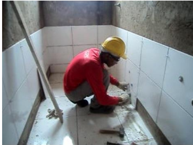
Fixação da lajota na parede
