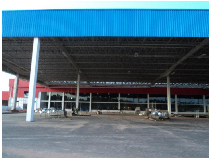
Fotos do prédio em fase de acabamento (3)
