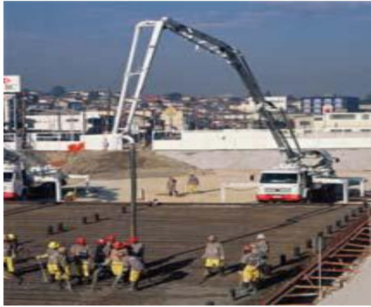
(Fig. 3) Caminhão Bomba transportando massa.
