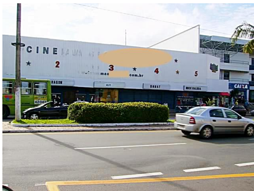
Antiga fachada da empresa C
